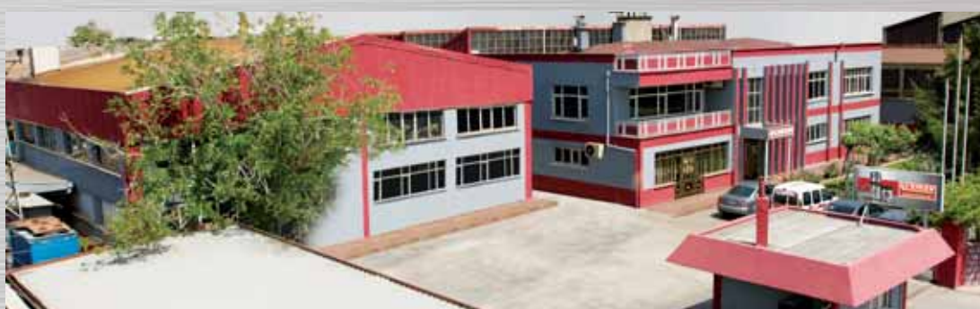
Fabrica de Camisa de Motor
